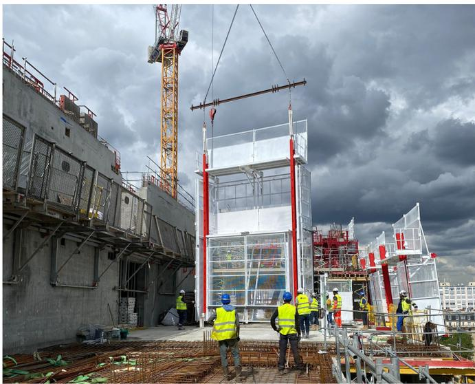
*Protection façade* (éléments en acier que l'on fait monter au fur et à mesure que la construction progresse, en guise de protection contre les chutes (garde-corps) et les intempéries).
